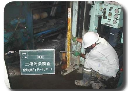
エコプローブによるボーリング調査
