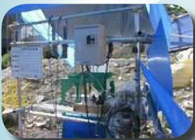
地下水調査 深度 100m 地下水
